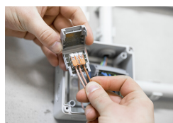
Verdrahtete Klemme in die Gelbox einlegen.
